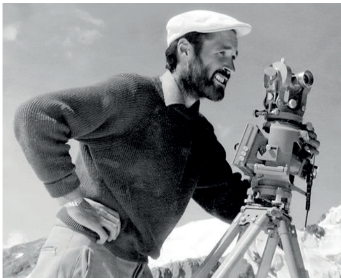
Abb. 1: Ernst Spiess bei stereophotogrammetrischen Aufnahmen mit dem Phototheodoliten im Panta-Gebiet, Peru, 1959 (Foto: E. Spiess)
